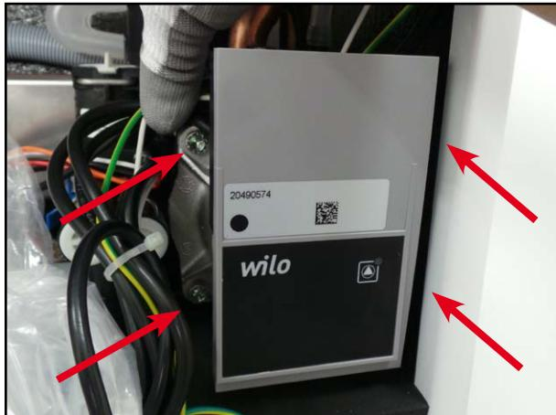
Individuare le 4 viti di fissaggio del motore della pompa al gruppo idraulico di ritorno.
