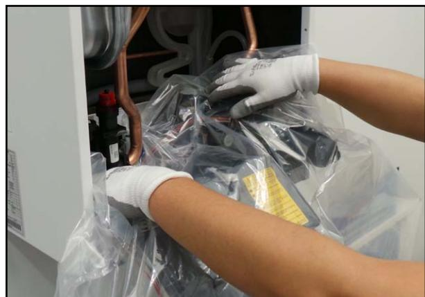
Stendere un telo protettivo in plastica nella parte inferiore dell'apparecchio.
